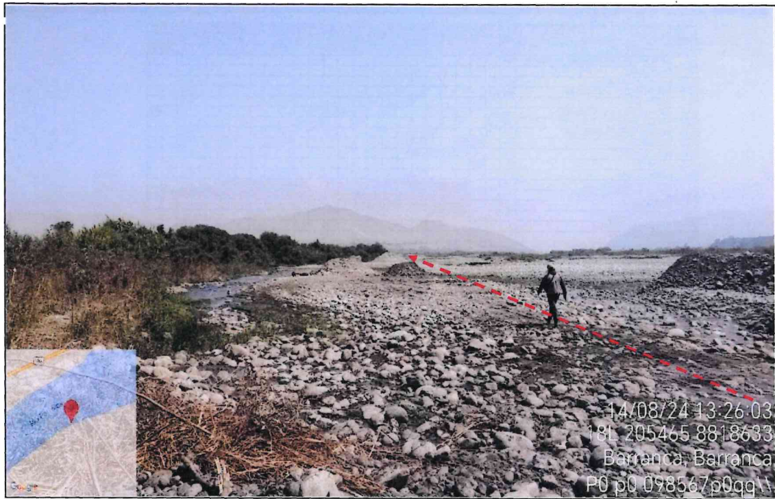
FIGURA N°02: MARGEN IZQUIERDA DEL RIO PATIVILCA EROSIONADO Y CAUCE COLMATADO, DESPROTEGIDO ANTE CRECIDAS DEL RIO EN EL SECTOR VINTO, DISTRITO DE BARRANCA, PROVINCIA DE BARRANCA - DEPARTAMENTO DE LIMA.
